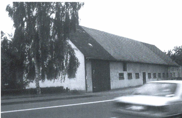
Der neue Stall an der Paderborner Straße, Foto: Aloys Kullmann
